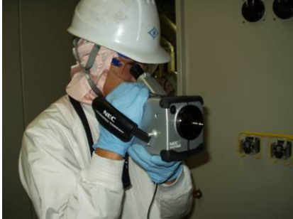
熱画像装置による測定(撮影)状況
